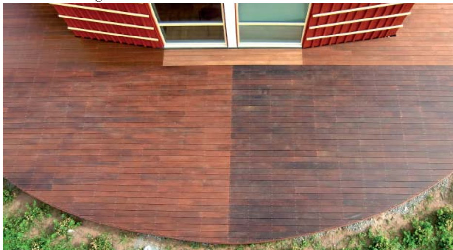
Långtidsprovning av olika ytbehandlingar pågår i fullskala sedan 2010 på Träcentrum, Nässjö.
