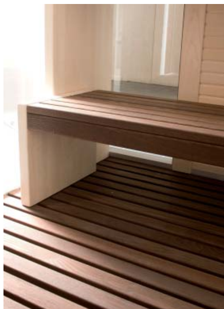
Värmebehandlad ask som både bastulav och golv.
